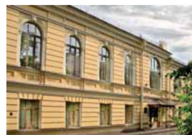
Учебный корпус № 4 (пр. Обуховской обороны, д. 85/2)
